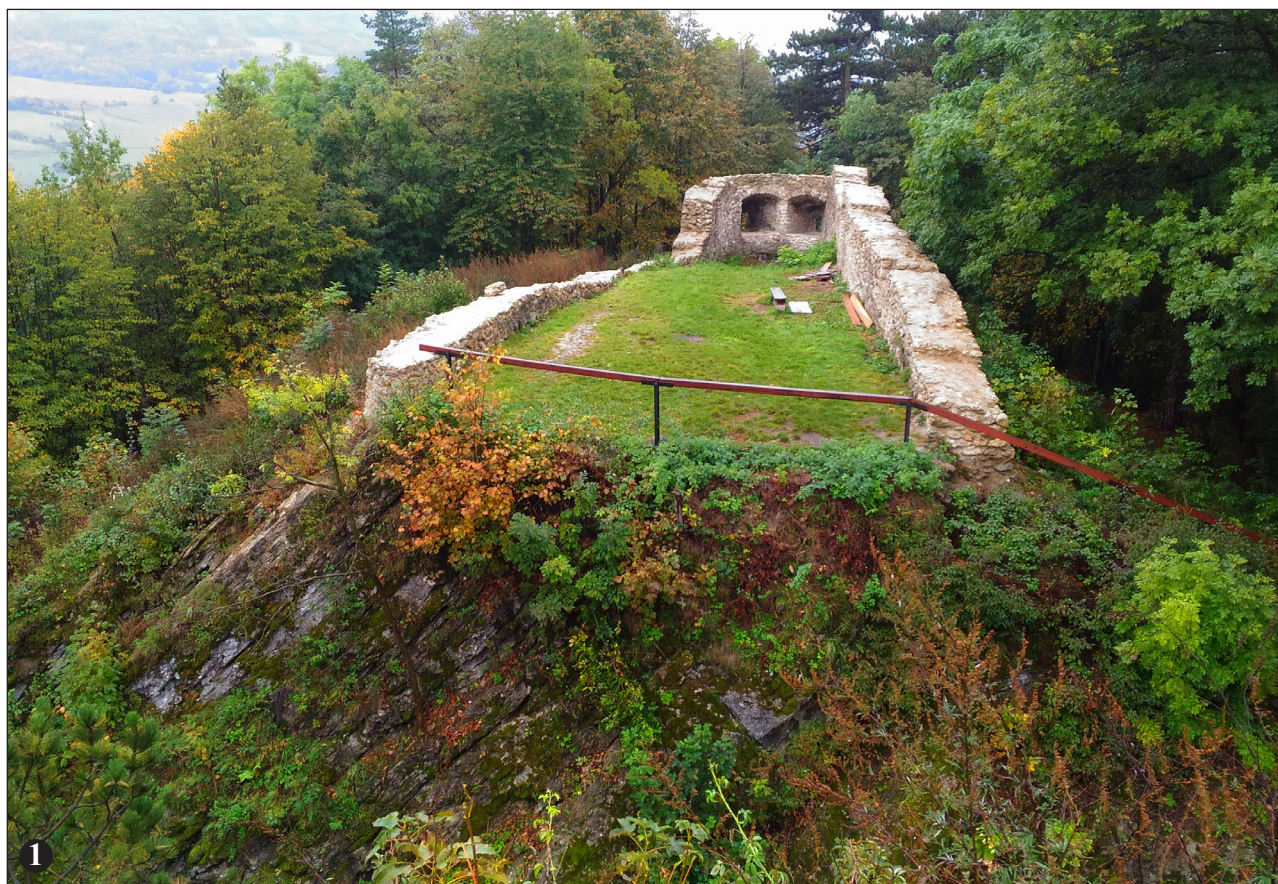
Obr. 1. Geologická stavba podloží je zřetelně patrná v hradním obranném příkopu. – Foto M. Šarina
